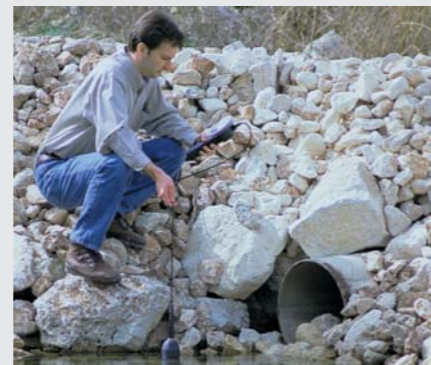
Mesure ponctuelle de la qualité de l'eau à la sortie d'une bouche d'égout
